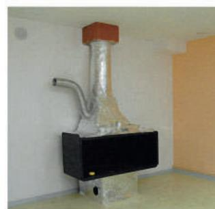
Isolation et raccordement des gaines de sortie d'air chaud
